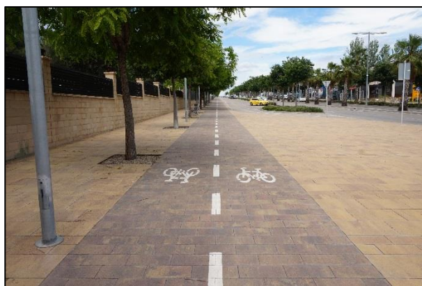
Fig. 32: Vorera bici paral·lela a la carretera C-246a.
