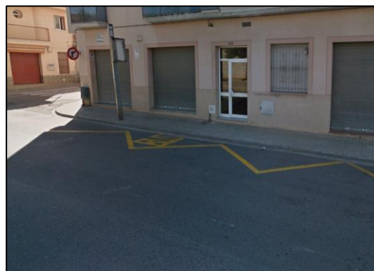
Parada d'autobús amb una accessibilitat deficient per amplada de vorera insuficient i per qual no adaptat
