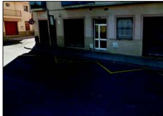
Parada d'autobús amb una accessibilitat deficient per amplada de vorera insuficient i per qual no adaptat
