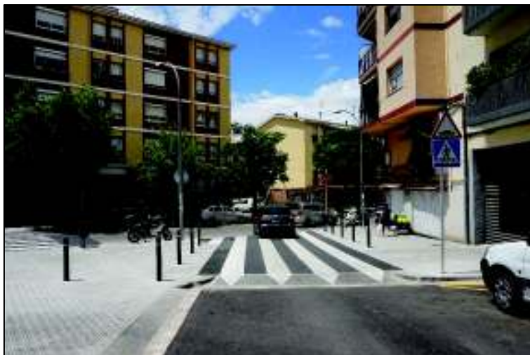
Fig. 45: Element reductor de velocitat al carrer Prat de la Riba. Font: Elaboració pròpia.
