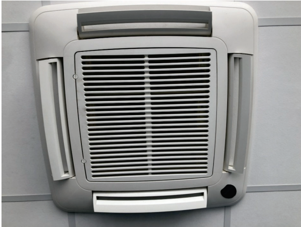
Figures 7 i 8: Fancoil de sostre tipus k7 i placa tipus
