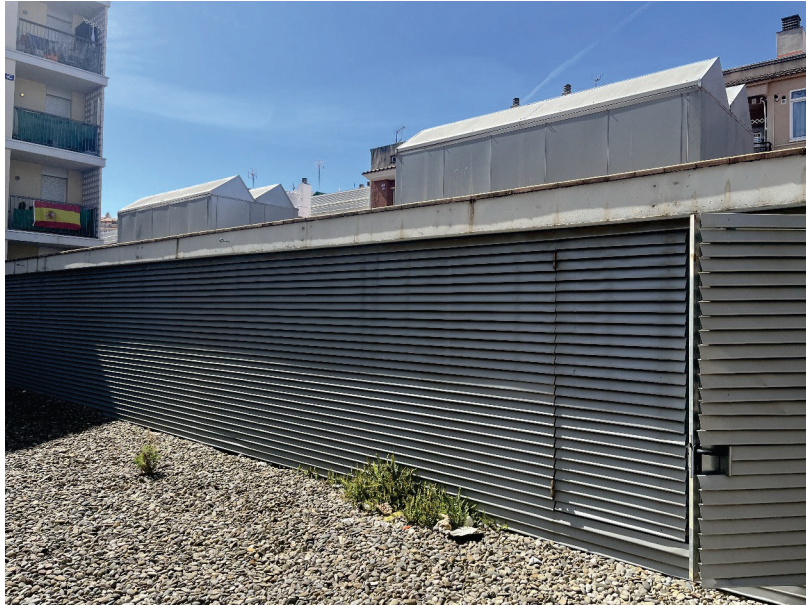
Figura 10: Tancament de lames exterior a desmuntar per entrar la maquinària.
