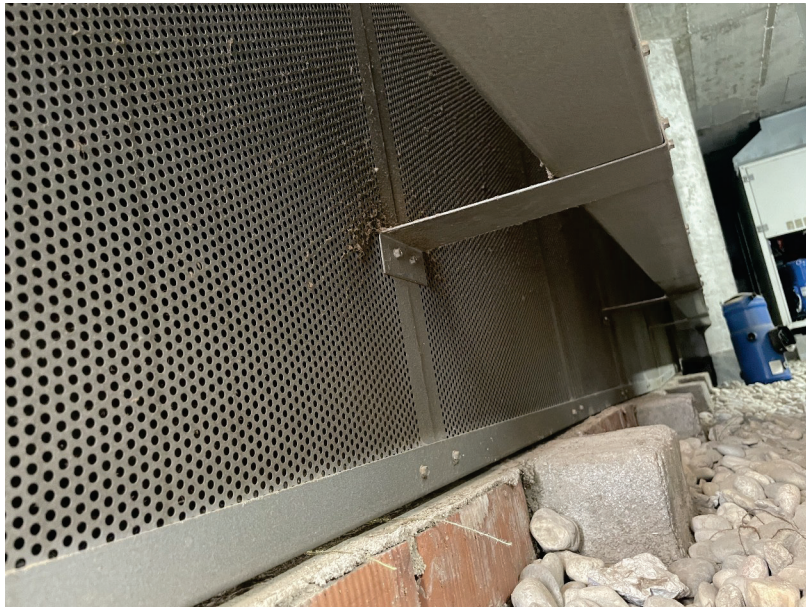
Figura 13: Detall gero a repicar i detall soportació panells atenuació soroll.
