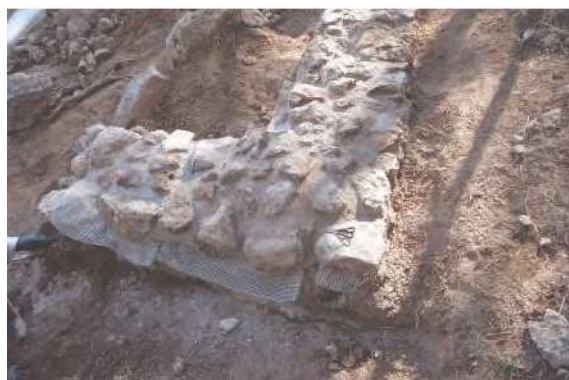
D'esquerra a dreta: Fotografia del procés de segellat de les parts baixes dels murs amb morter de calç. Fotografia de la restitució volumètrica d'un dels murs, amb la col·locació d'una filada de pedres lligades amb morter de calç sobre la malla T per diferenciar-ho de les restes originals.
