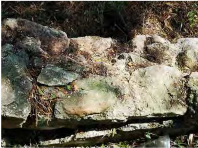
Figura 32. Detall del revestiment interior del mur 107
