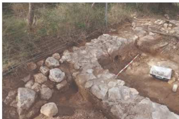
Fotografies del procés de rejuntat dels murs amb morter de calç.
