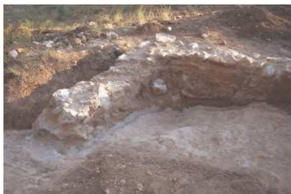
D'esquerra a dreta: Fotografia del procés de segellat de les parts baixes dels murs amb morter de calç. Fotografia de la restitució volumètrica d'un dels murs, amb la col·locació d'una filada de pedres lligades amb morter de calç sobre la malla T per diferenciar-ho de les restes originals.
