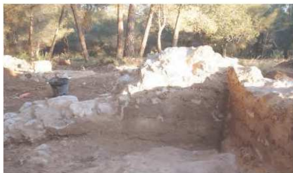
D'esquerra a dreta: Fotografia del procés de segellat de les parts baixes dels murs amb morter de calç. Fotografia de la restitució volumètrica d'un dels murs, amb la col·locació d'una filada de pedres lligades amb morter de calç sobre la malla T per diferenciar-ho de les restes originals.
