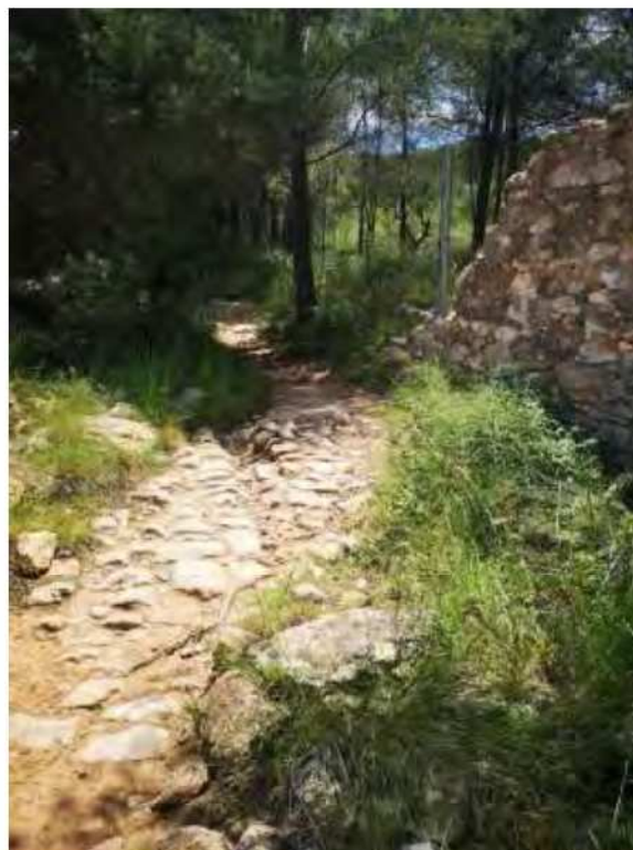
Figura 35. Vista del camí (108) a prop de la riera de Ribes
