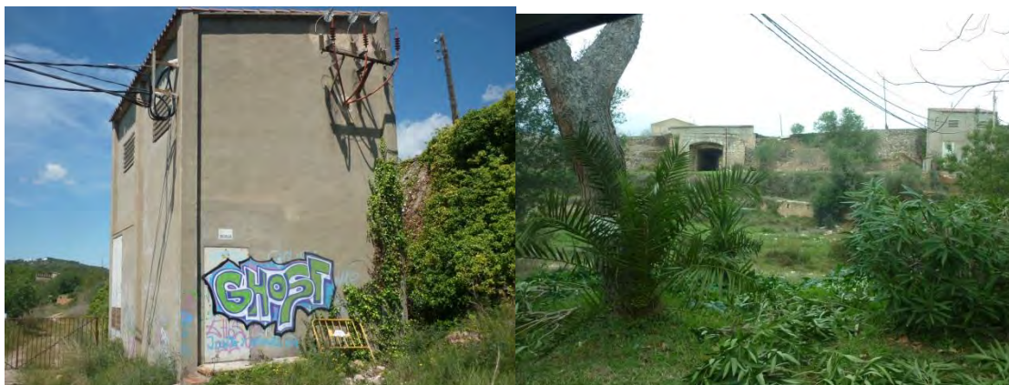
Estació transformadora existent situada al costat de l'autòdrom.
