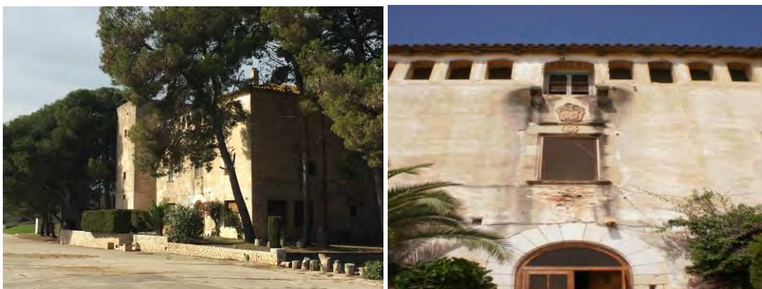
Edificacions de l'Autòdrom Terramar: Clot dels Frares. Estat actual
