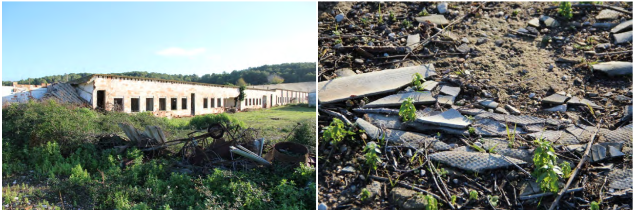
Imatge 12. Presència de residus i restes d'amiant
